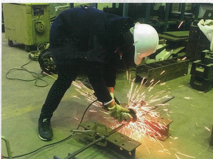
土木系參賽學生製作鋼橋。
